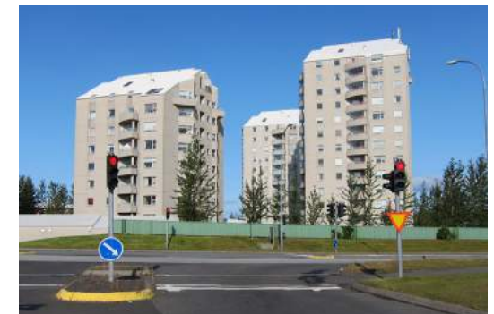
Smárahvammsvegur og Gullsmári.
