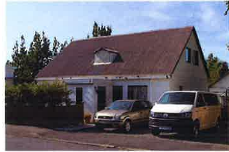
Álftröð 3 árið 2019 (Ljósmynd T.ark)
