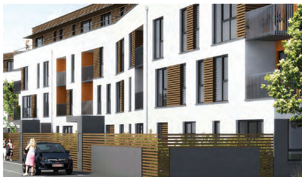
F6 - Vönduð girðing á lóðamörkum Housing HA, Brussels. Bureau d'Architectes Emmanuel Bouffroux.
