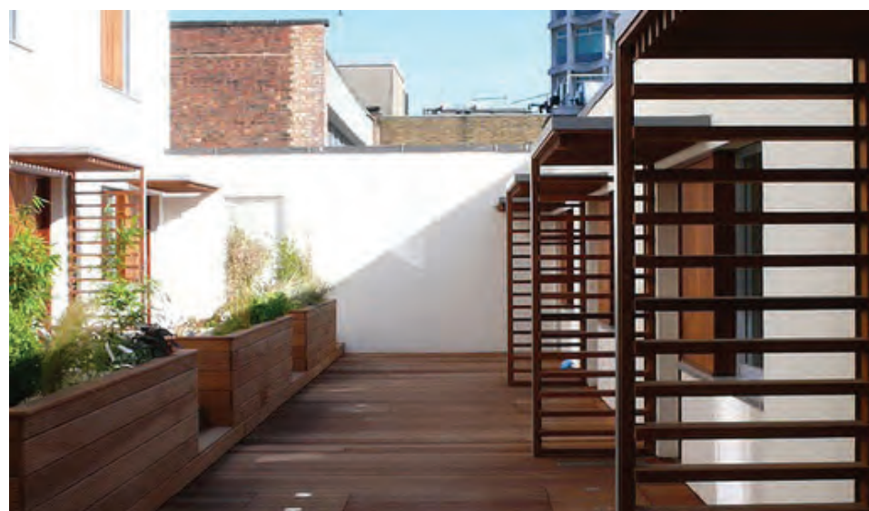
F7 - Inngangar í hús og afmörkun milli sérafnotareita Hancock Lofts, California. Koning - Eizenberg Architects.
