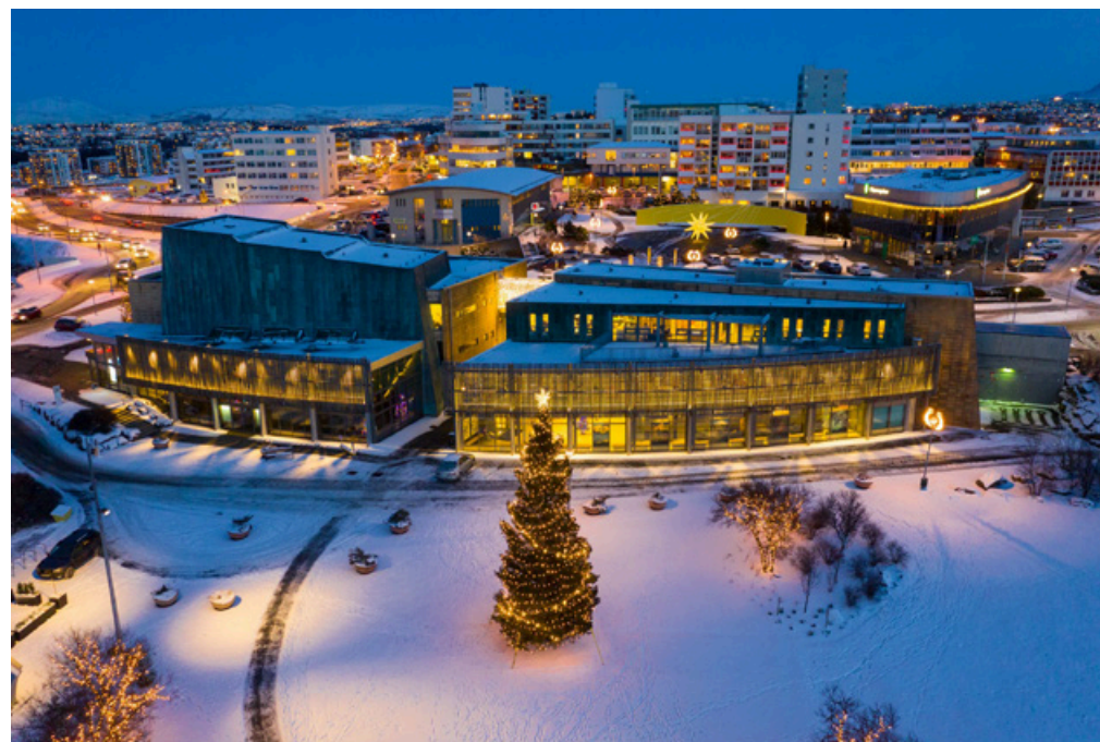
Mynd 1-2. Menningarhúsin í Kópavogi.
