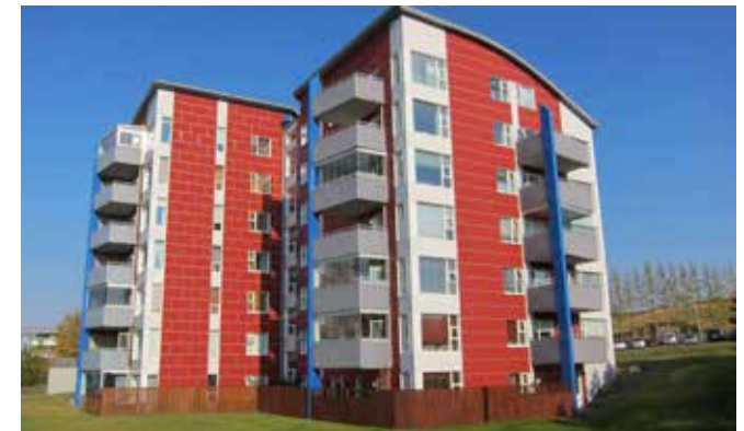
Fjölbreytt byggð og litaval í hverfiseiningu F2C.
