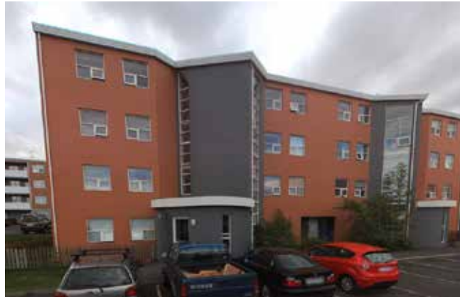
Fjölbýlishús við Fífulind, hverfiseining F3A.
