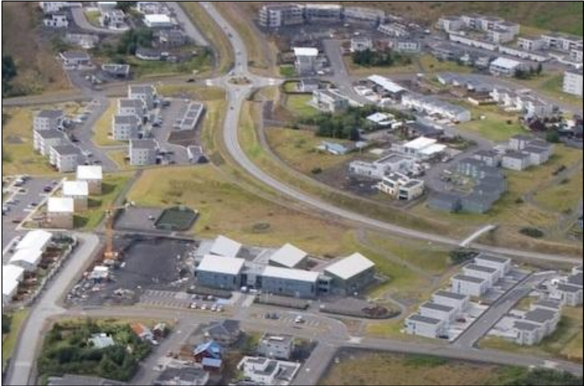
Mynd 57. Vatnsendaskóli 2009. BM
