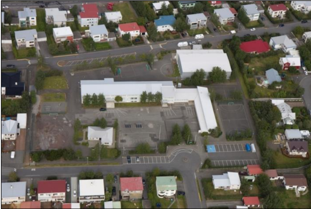
Mynd 20. Kársnesskóli – Skólagerði 2009, á móti suðri. BM
