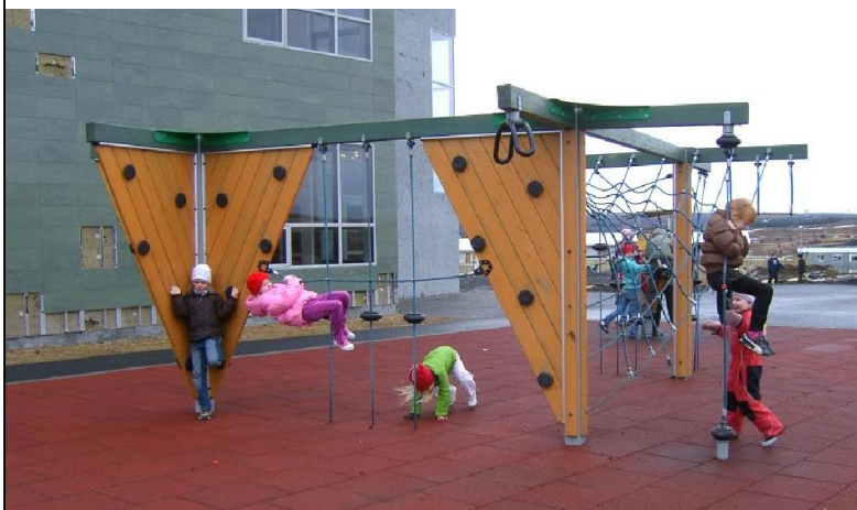
Mynd 4. Gúmmíhellur sem undirlag (falldempun) klifurtækis við Vatnsendaskóla. FB
