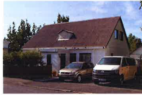
Álftröð 3 árið 2019 (Ljósmynd T.ark)
