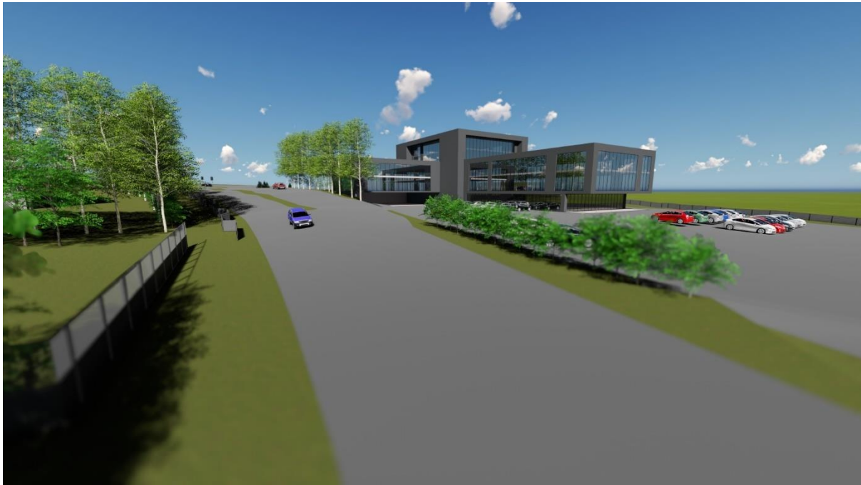
Mynd 6 Ásýnd húsnæðis að Dalvegi 32 eftir uppbyggingu.
