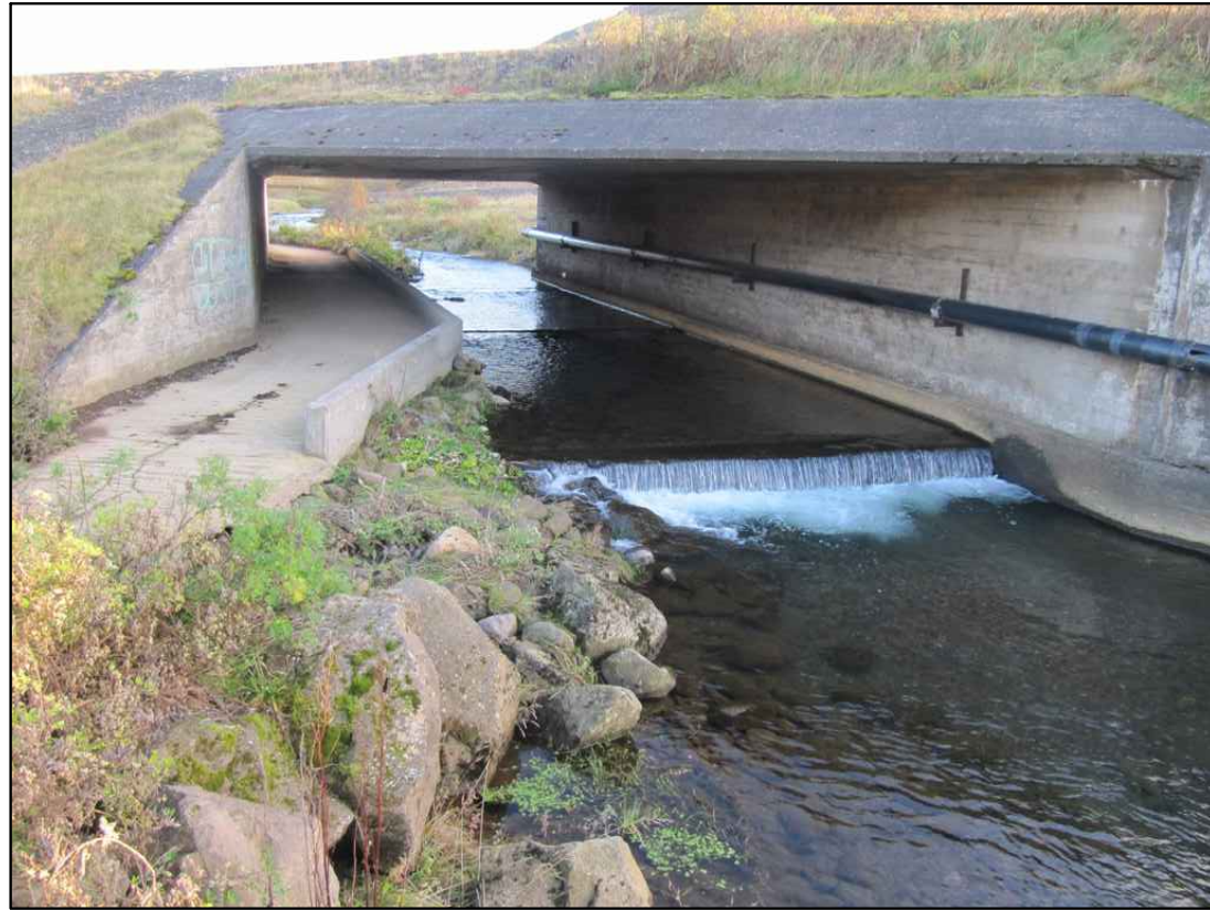
TIL VIÐMIÐUNAR VEGBRÚ YFIR SUBURÁ Á ÞINGVALLAVEGI, HORFT TIL SUBURS. REIÐGATA UNDIR BRÚ, breidd 2.65m, hæð undir brúargölf 2.57 m, hæð á kanti 0.4 m,
