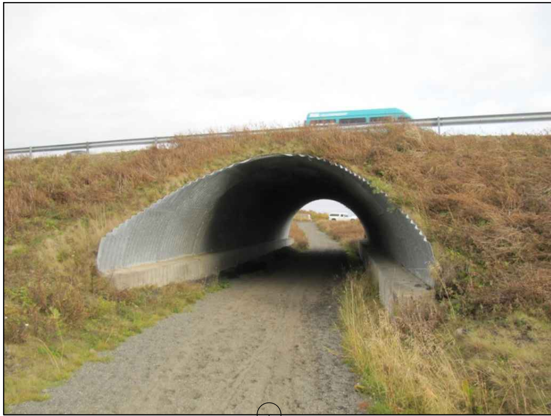
TIL VIÐMIÐUNAR REIÐGÖNG UNDIR SUBURLANDSVEG NEÐAN FJÁRBORGAR. STÆRÐ Á REIÐGÖNGUM breidd 5.8 m, hæð 4.3 m SAMKVÆMT REIÐVEGABÓK VR OG LH SKAL RÝMI Í REIÐGÖNGUM VERA MINNST breidd 3.0 m og hæð 3.0 m.
