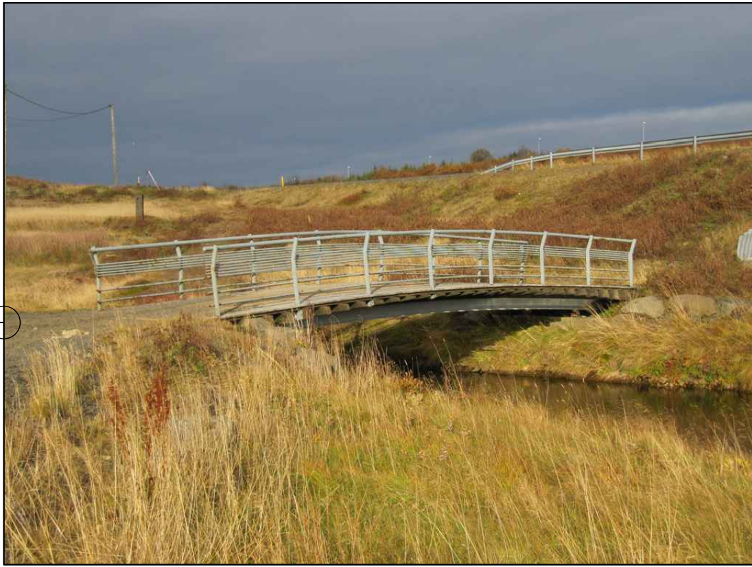
TIL VIÐMIÐUNAR REIÐBRÚ YFIR HÓLMSÁ NEÐAN FJÁRBORGAR. STÆRÐ Á REIÐBRÚ, breidd 2.60 m, lengd 11.0 m
