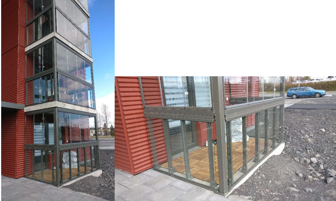
Mynd 2: Dæmi um svalalokanir sem eru ekki þéttar (sjá t.d. bil milli glerja á hornum) sem geta samt gefið 10 dB hljóðdempun.
