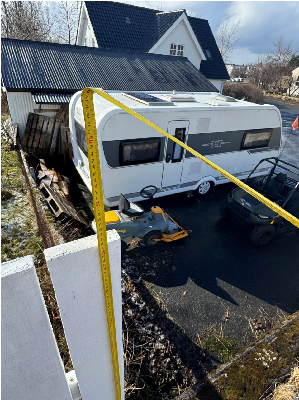
Mynd 7 Mögulegt væri að setja sambærilega girðingu á vegginn á lóðamörkum til að sporna gegn því að krakkar eða aðrir færu upp á þakið. Þessi girðing er á lóðinni við hliðina.
