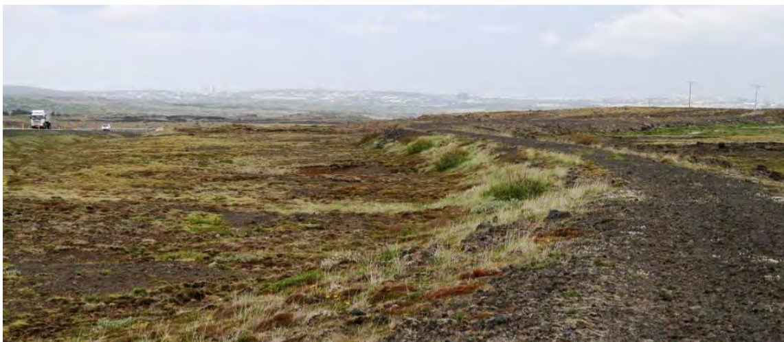
Mynd 4-3 Varnargarður sem beinir Fossvallaá til norðurs frá vegi.
