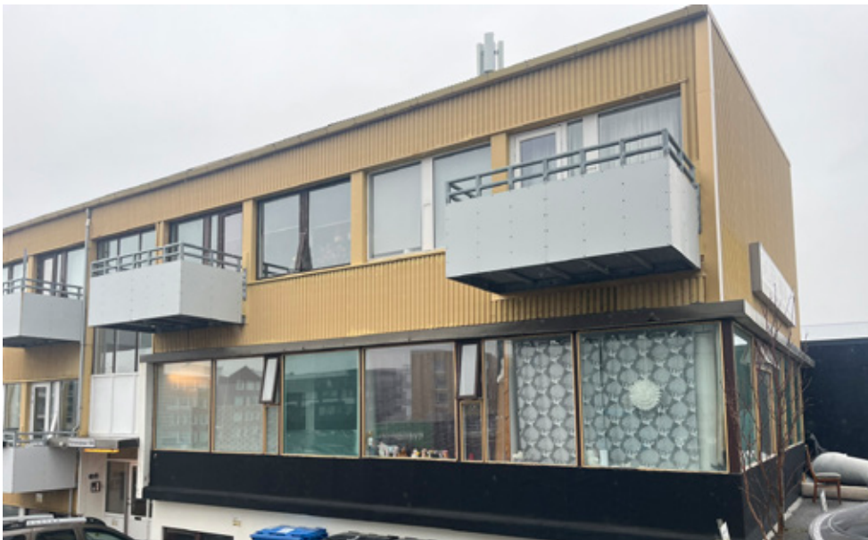
Kórsnesbraut 106 er flokkað sem einstakt hús í rauðum flokki skv. byggðak.
