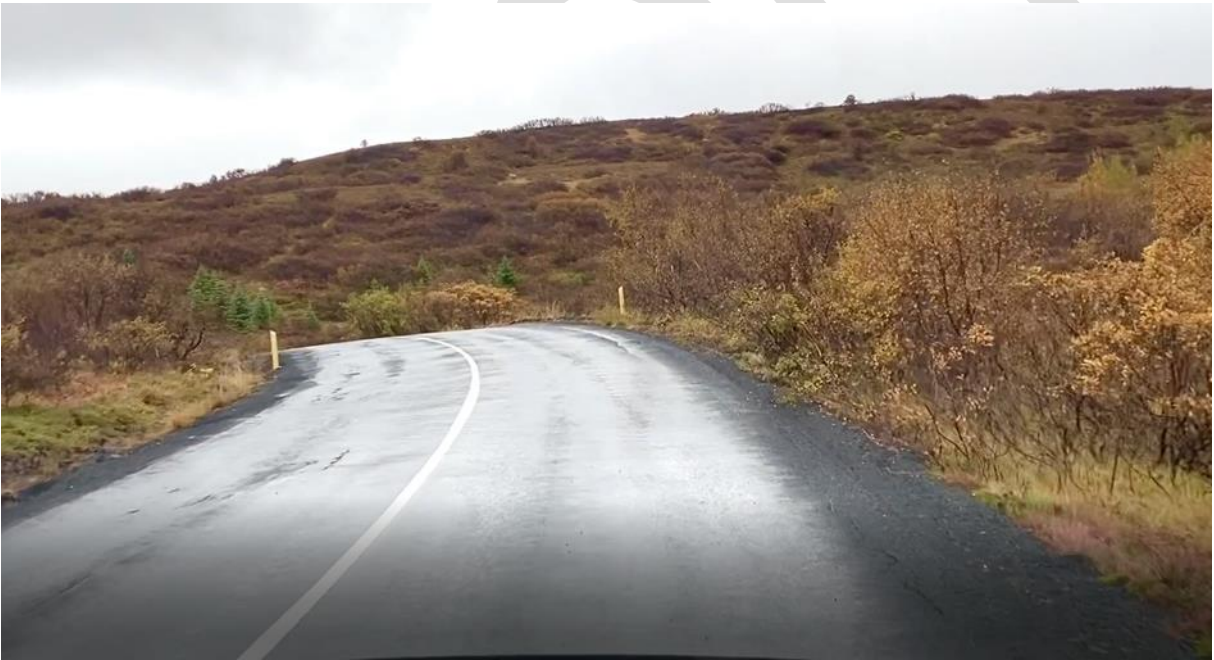
MYND 8 Skert vegsýn áður en komið er að bílastæði við Stekkjartún, ekið í norður okt. 2020.
