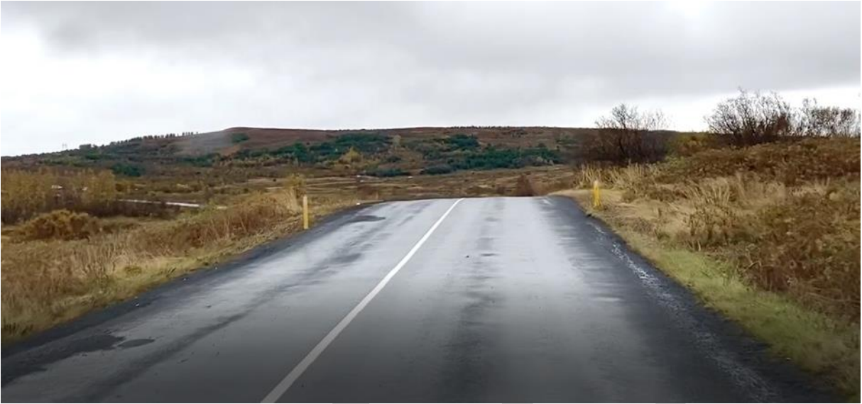
MYND 9 Skert vegrýn áður en komið er að Vífilsstaðalæk vegna hæðarlegu vegar, ekið í norður okt. 2020.
