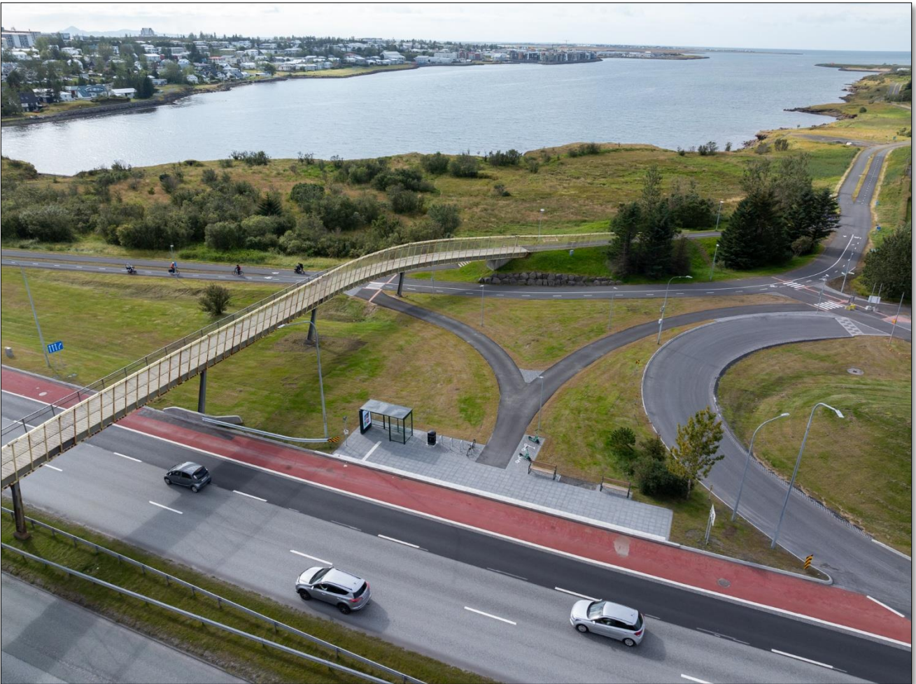
Nýjar strætóstöðvar við Fossvog.
