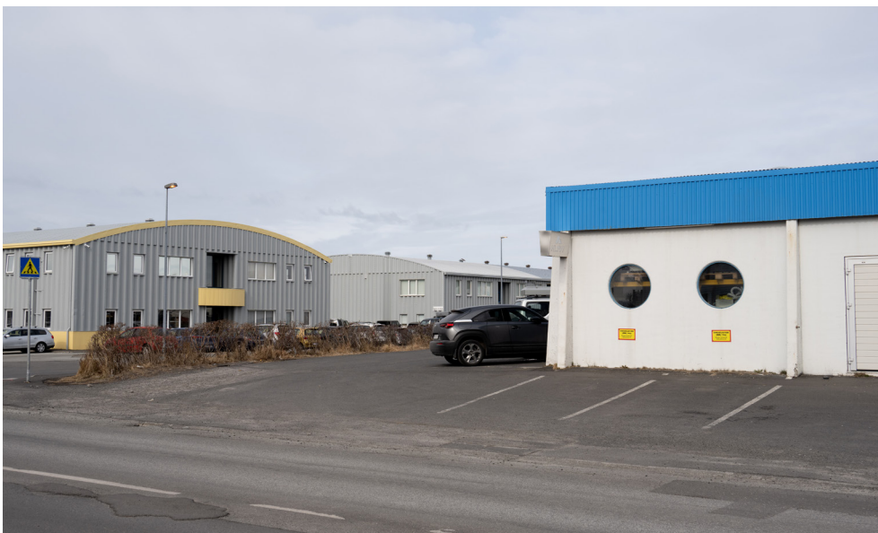
Snyrtileg yfirbragð og nýlegt atvinnuhúsnæði.
