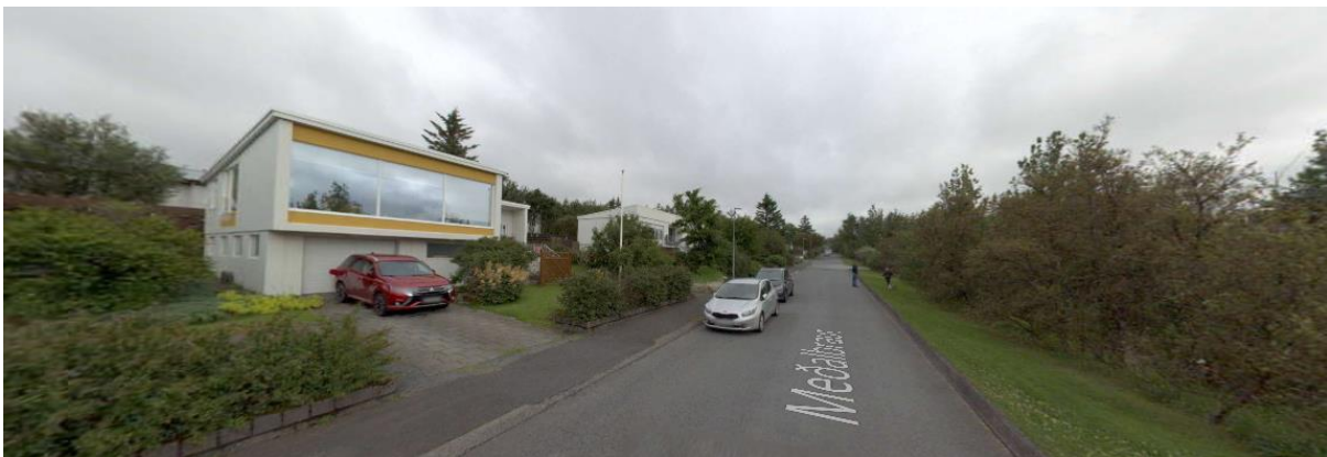
Yfirbragð byggðar. Meðalbraut 14 og 16. Form og útlit.
