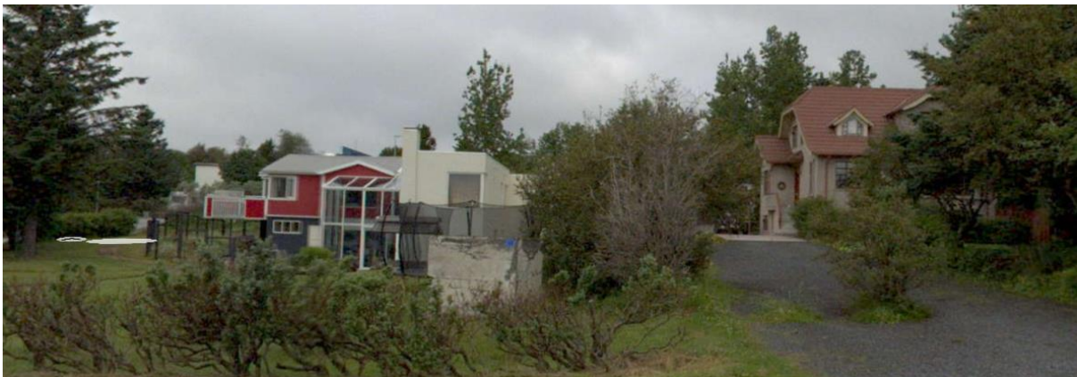
Yfirbragð byggðar. Form og útlit Kópavogsbrautar 8 og 10.
