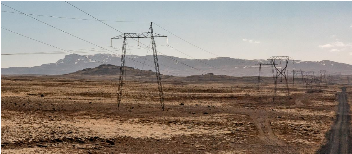
MYND 3 Núverandi KH1 (t.v. á mynd) með stöguðum stálgrindarmöstrum.
