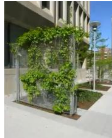
MYND 33 Dæmi um skjólveggi. Hægri: Gegnheilir skermar sem er dreift um svæðið. Vinstri: Skermur sem er gerður úr neti og gróðri og hleypir hluta af vindi í gegn.
