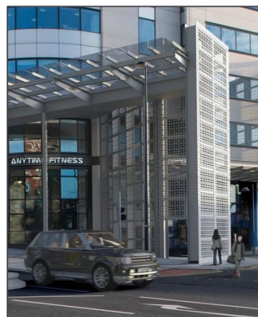
MYND 36 Dæmi um skyggni og yfirbyggingar til að draga úr niðurstreymi frá hlið hárra bygginga (e. downwash). Á myndinni lengst til hægri er blandað saman skyggnum og lóðréttum skermum til að bæta vindafar við jörðu.
