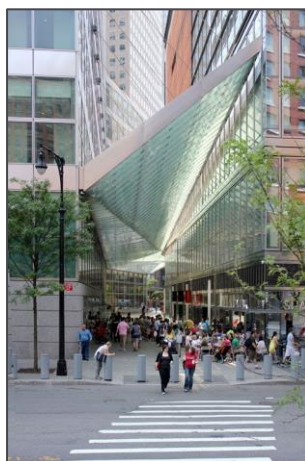
MYND 36 Dæmi um skyggni og yfirbyggingar til að draga úr niðurstreymi frá hlið hárra bygginga (e. downwash). Á myndinni lengst til hægri er blandað saman skyggnum og lóðréttum skermum til að bæta vindafar við jörðu.
