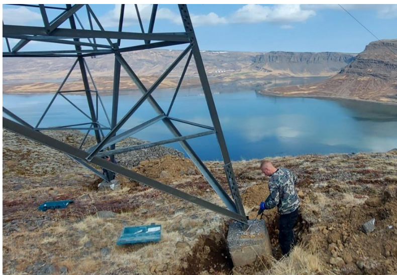
MYND 4 Frá viðgerð á undirstöðum vegna Brennimelslínu.
