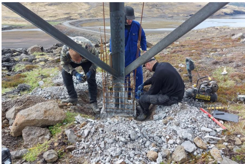
MYND 5 Frá viðgerð á undirstöðum Brennimelslínu.
