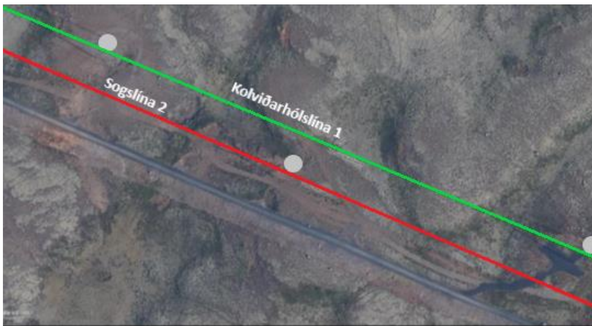
MYND 10 Á mynd sjást tvö möstur Kolviðarhólslínu 1 (gráir punktar við græna línu) Samhliða sést dökkur vegurinn (aðkomuvegur) og ljósari línuslóði. Á mastri Kolviðarhólslínu 1 hægra megin á mynd hefur slóði verið endurnýjaður ásamt mastursplani (dekkri slóð). Þörf er á sambærilegri framkvæmd á mastri á Kolviðarhólslínu 1 vinstra megin á mynd. Slóð milli mastra yrði ekki nýtt við framkvæmdina.
