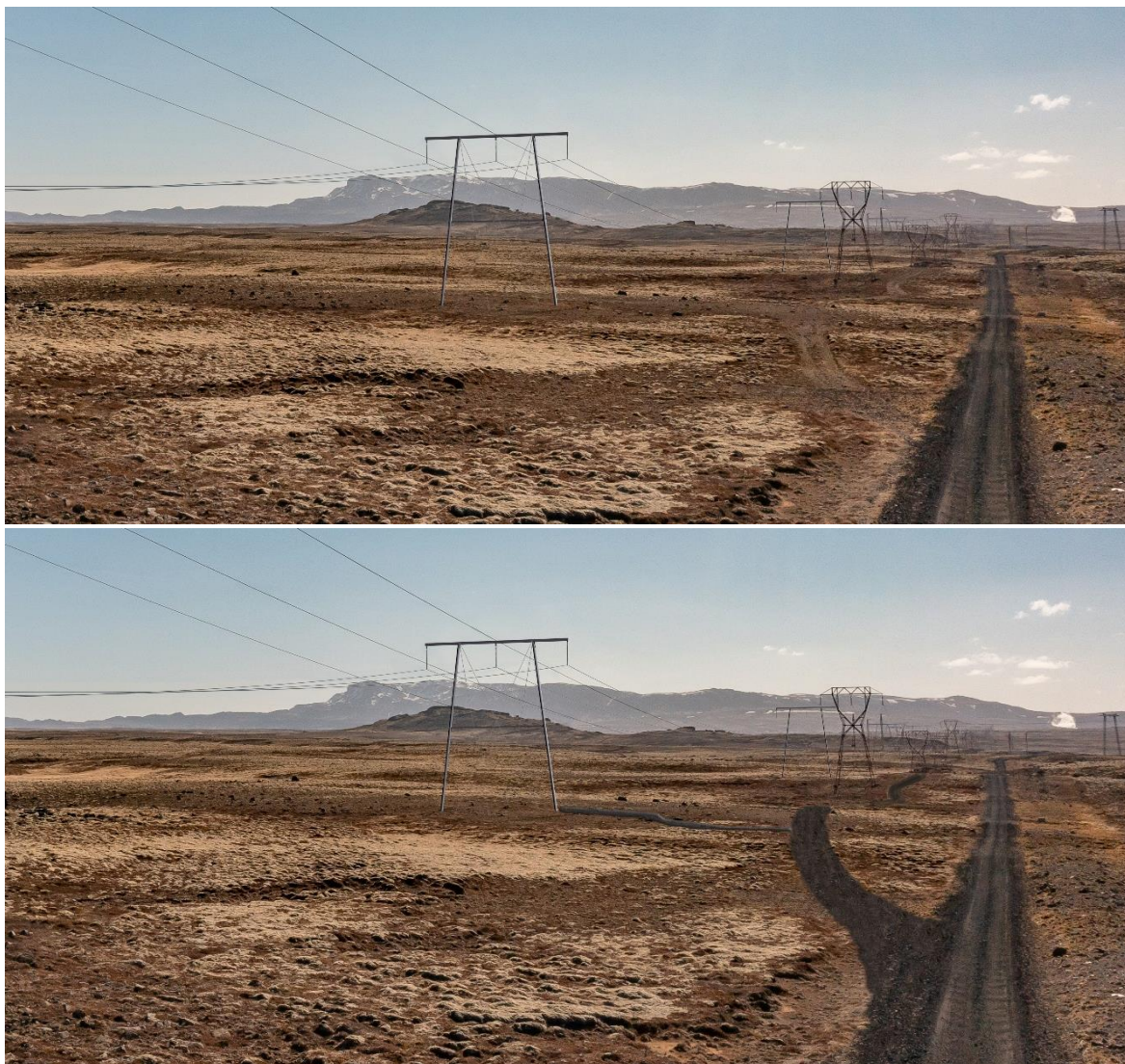
MYND 8 Dæmigert mastur Kolviðarhólslínu 1, og aðstæður þar sem endurnýja þarf vegslóða frá veginum sem liggur meðfram línunni. Efsta mynd sýnir núverandi stálgrindamastur og óstyrkta vegslóða. Mynd fyrir miðju sýnir endurnýjað stálörörmastur og neðsta mynd stálörörmastur ásamt styrkingu vegslóða út frá núverandi vegi.
