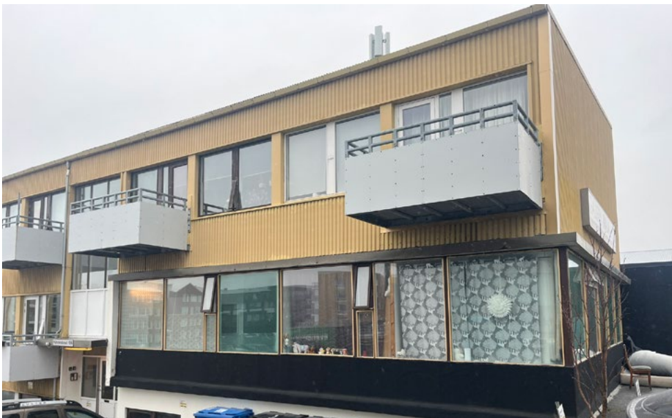
Kórsnesbraut 106 er flokkað sem einstakt hús í rauðum flokki skv. byggðak.
