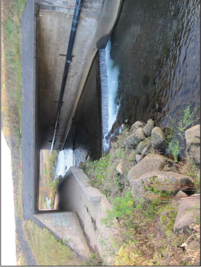
TIL VIBMUNAR VEGBRÚ YFIR SUÐURÁ Á ÞINGVALLAVEGI, HORFT TIL SUÐURS. REIDGATA UNDR BRÚ, BREIDD 2.65m, HÆÐ UNDR BRÚARGÖLF 2.57 m, HÆÐ Á KANT 0.4 m.
