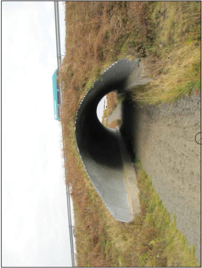
TIL VIBMUNAR REIDGÖNG UNDR SUBURLANDSVEIG NEDAN F JÁRBORGAR. STÆRÐ Á REIDGÖNGUM BREIDD 5.8 m, HÆÐ 4.3 m SANKVÆMT REIDVEGABOK VR OG LH SKAL RYMI Í REIDGÖNGUM VERA MINNST BREIDD 3.0 m OG HÆÐ 3.0 m.
