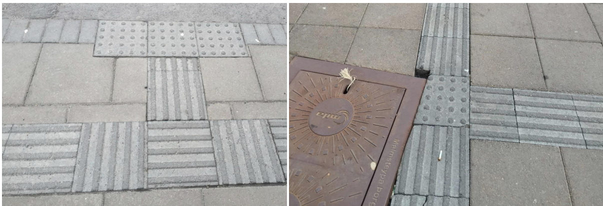
Mynd 4-25 Myndirnar sýna leiðarlínur við þveranir. Á mynd til vinstri er bent á stefnubreytingu með því að snúa stefnufleti þvert á göngustefnu. Blindir og sjónskertir eiga erfitt með að gera sér grein fyrir stefnubreytingunni við slíka útfærslu og kjósa frekar að hafa áherslu- og varúðarsvæði. Varúðarsvæði við þverunina er lítið (30cm djúpt) sem getur gert að verkum að fólk nær ekki að gera sér grein fyrir gatna- og stígamótum nógu tímanlega og gengur því út á götu. Á mynd til hægri er varúðarsvæði minnkað vegna brunns. Hér er varúðarflötur ekki nægilega stór til að blindir og sjónskertir geri sér grein fyrir gatna- og stígamótum. Frágangur eins og sést við horn á brunni getur einnig orsakað fallhættu (Myndir: Rannveig Traustadóttir).
