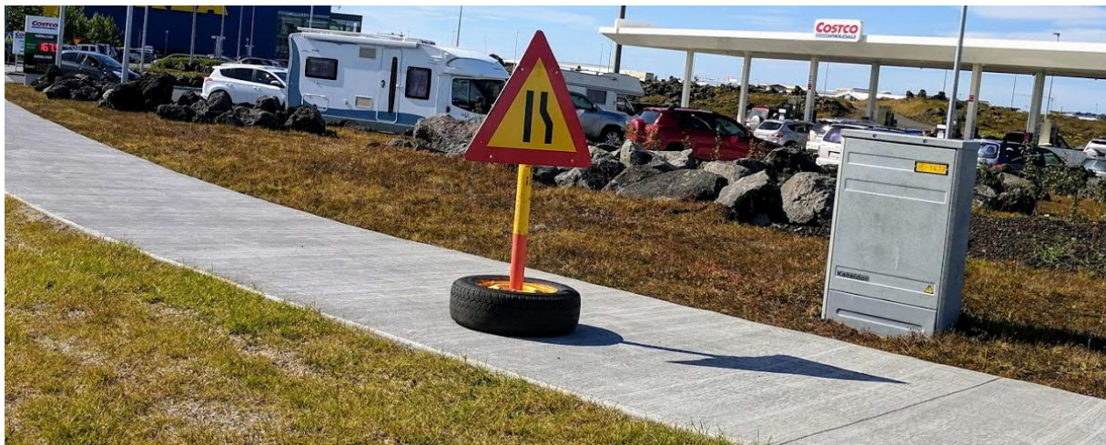
Mynd 3-3 Vegmerking sem er staðsett á göngu- og/eða hjólastíg skapar hindrun fyrir gangandi og hjólandi vegfarendur. Manneskja með göngugrind eða í hjólastól hefði átt í erfiðleikum með að komast framhjá skiltinu (Mynd: Haraldur Karlsson 2017).
