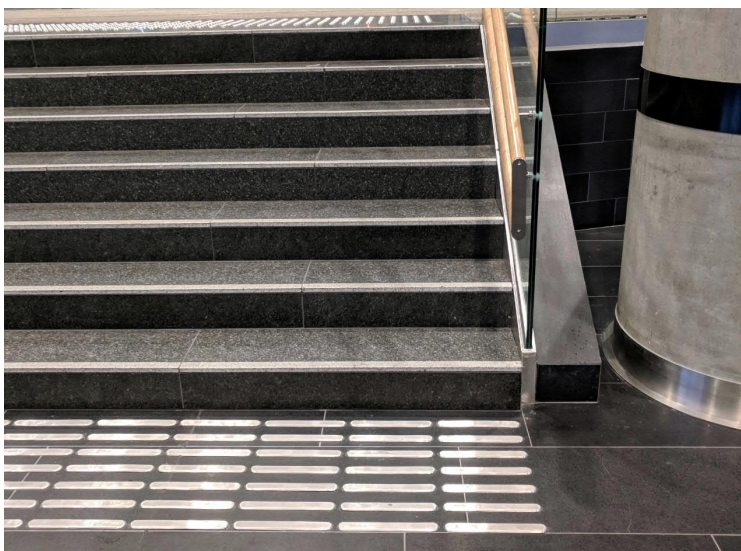
Mynd 4-47 Trappa með áherslusvæði við efstu og neðstu tröppu. Merkingar eru framan á tröppunefi og handlistar í öðrum lit en nærliggjandi umhverfi. Handlistarnir ná 30 cm út fyrir neðstu og efstu tröppu (Mynd: Berglind Hallgrímsdóttir).
