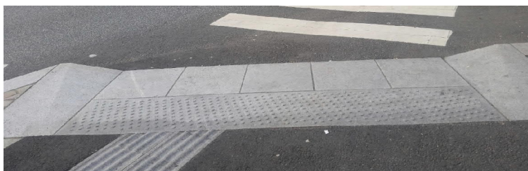
Mynd 4-21 Myndin sýnir útfærslu sem er villandi. Áhersluflötur liggur ekki þvert á göngustefnu og því er sá sem er blindur eða sjónskertur leiddur skáhallt yfir götuna. Það tekur lengri tíma og getur leitt einstaklinginn í ógöngur (Mynd: Áslaug Katrín Aðalsteinsdóttir).
