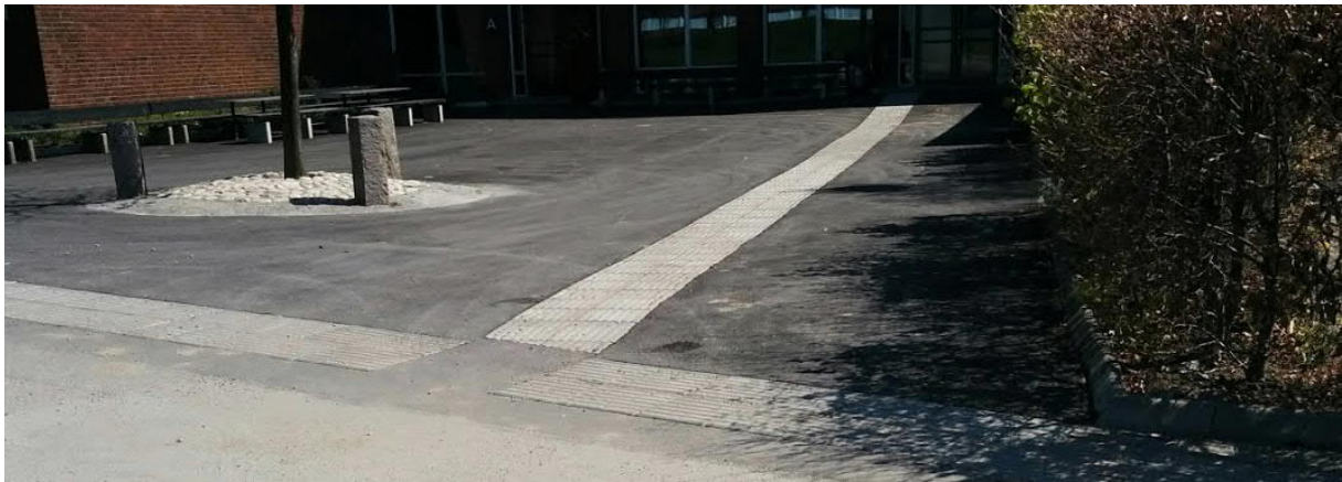
Mynd 4-9 Á stórum opnum svæðum er mikilvægt að geta leiðbeint blindum og sjónskertum um hvar leiðin liggir. Á þessari mynd leiða sértækar leiðarlínur blinda og sjónskerta að aðalinngangi skóla (Mynd: Berglind Hallgrímsdóttir).
