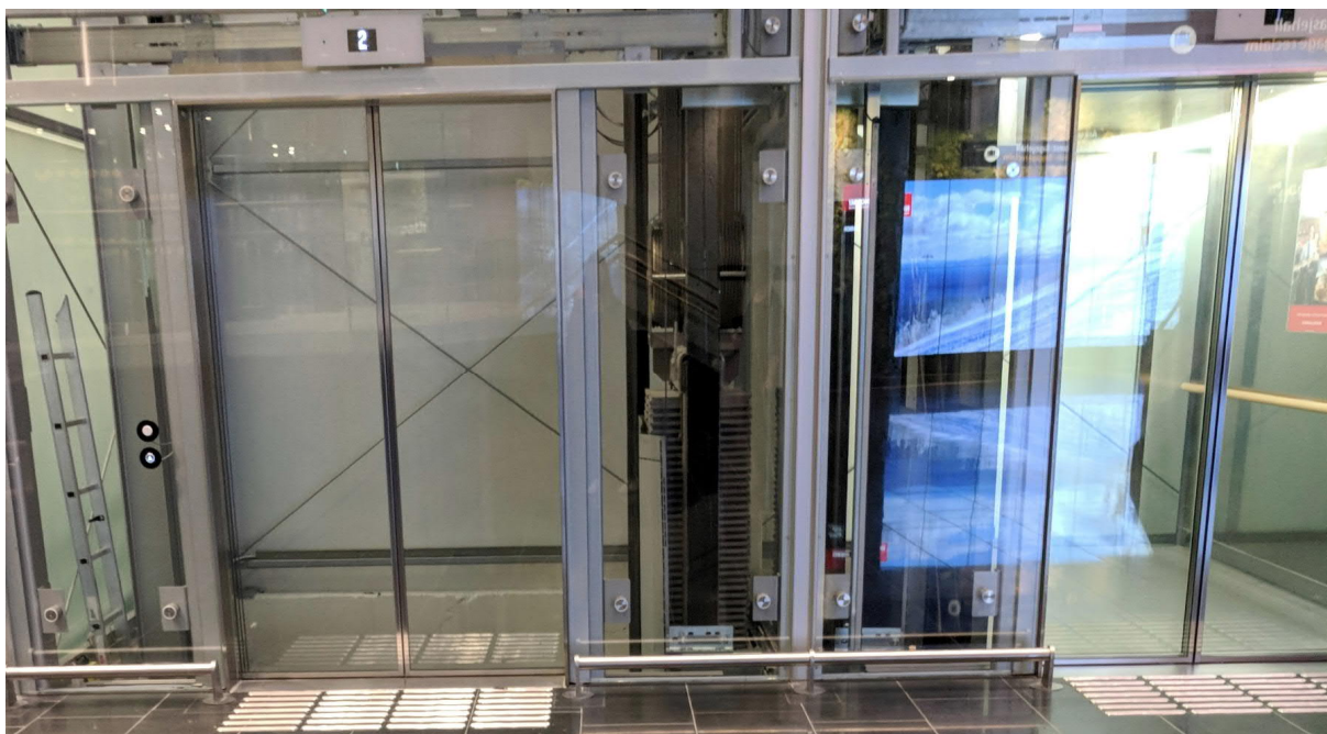
Mynd 4-49 Stefneiningar eru fyrir framan lyftudyr til að sýna staðsetningu þeirra (Mynd: Berglind Hallgrímsdóttir).
