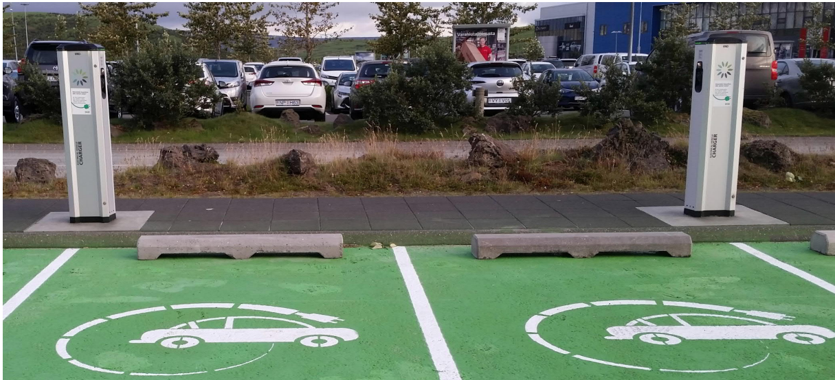
Mynd 4-39 Tryggja þarf að hleðslustaurar og innstungur séu ekki of hátt á staurnum því þá er erfitt fyrir lágvaxið fólk og fólk í hjólastól að komast að innstungunni (Mynd: Áslaug Katrín Aðalsteinsdóttir).
