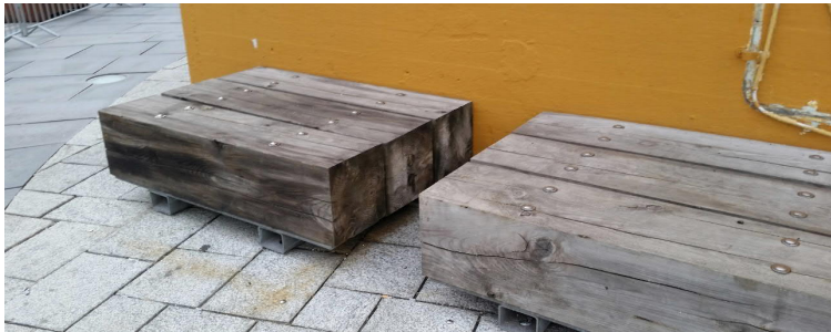
Mynd 4-4 Dæmi um bekk sem hentar aðeins hluta vegfarenda. Sætið er lágt og hvorki með sérstökum bak- eða armstuðningi (Mynd: Áslaug Katrín Aðalsteinsdóttir).
