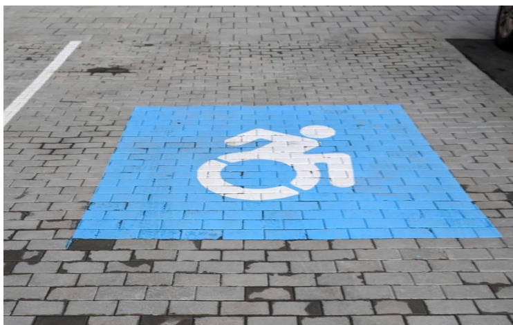
Mynd 4-33 Skýr merking, bílastæðamerki og rammi umhverfis. Ákjósanlegt er að hafa skilti framan við stæði svo staðsetning stæðisins sé einnig ljós þegar snjór hylur merkið (Mynd: Berglind Hallgrímsdóttir)
