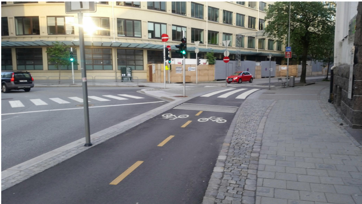
Mynd 4-7 Á myndinni má sjá skýr skil á milli vegfarendahópa, sjálfgefnar leiðarlínur eru beggja megin við gangstéttina og skýr kantur að hjólastíg (Mynd: Áslaug Katrín Aðalsteinsdóttir)
