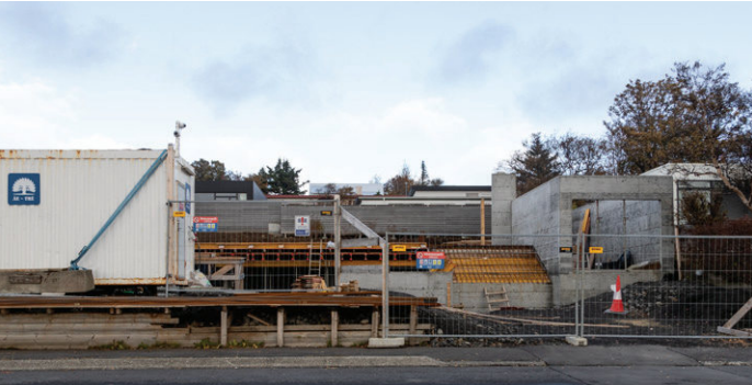
Niðurrif og uppbygging
