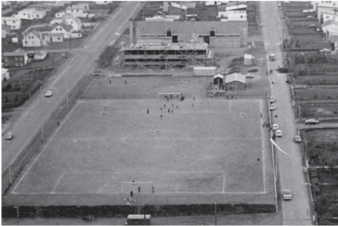
Mynd 163: Þinghólsskóli í byggingu og Vallargerðisvöllur í forgrunni, líklega um 1969.
