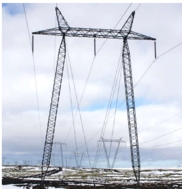
Mynd 4.3 Nýtt burðarmastur með tveimur jarðvírur.
