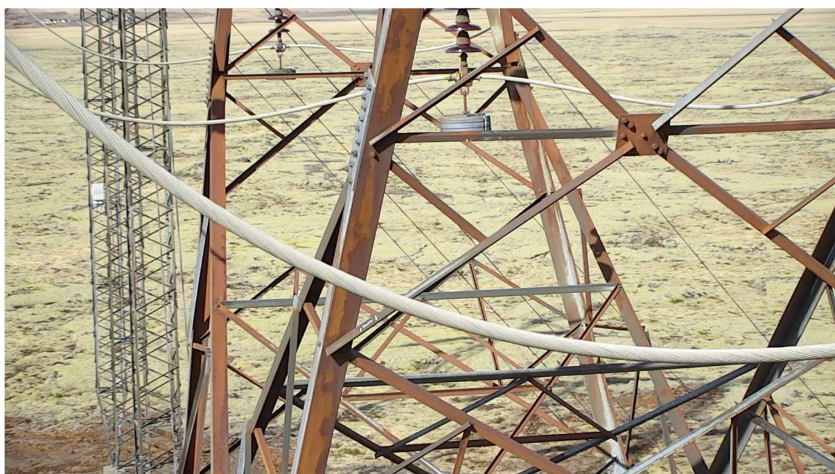
Mynd 3.1 Myndin er frá árinu 2019 og sýnir ryðmyndun í mastri 9 í KH1 (áður mastur 227 í BU2) sem stendur 3,5 km vestan tengivirkisins við Kolviðarhól. Þetta er eitt af þeim möstrum sem verður endurnýjað.
