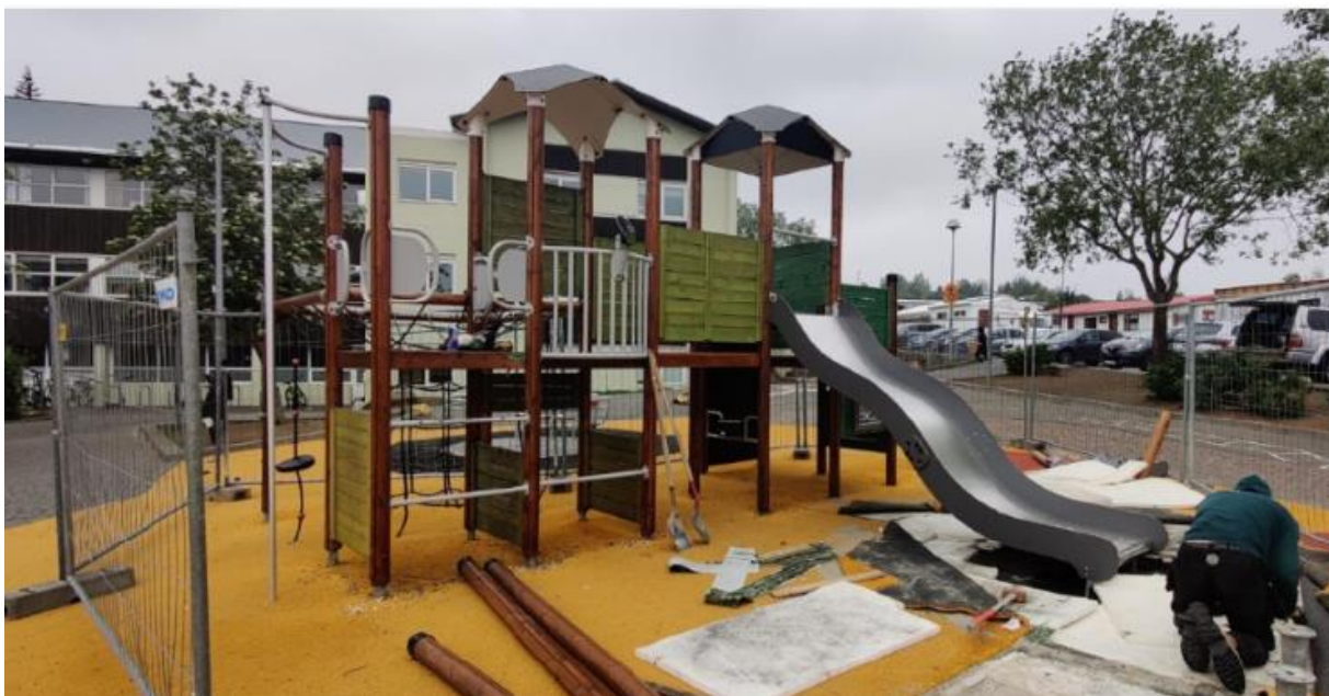
Mynd 1. Kastali á lóð Snælandsskóla. Unnið í júníbyrjun 2021 að frágangi undirlags (gervigras með 60mm falldempunarpúða (foam) við kastala á lóð Snælandsskóla, eftir breytingar á honum.
