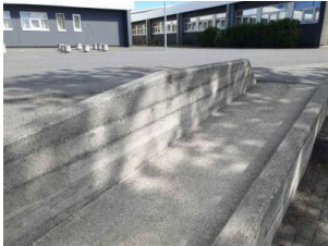
Fallhæð af kanti er yfir 60cm, þarf dempandi undirlag.
