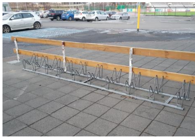
Myndir 10 og 11. Hjólastæði við Smáraskóla. Þau sem eru á mynd 11 fara ekki aðeins verr með hjólin heldur hafa þau einnig valdið slysum. Hraða þyrfti útskiptum á slíkum hjólagrindum og setja hjólaboga, eins og á mynd 10, eða sambærilegt í staðinn.
