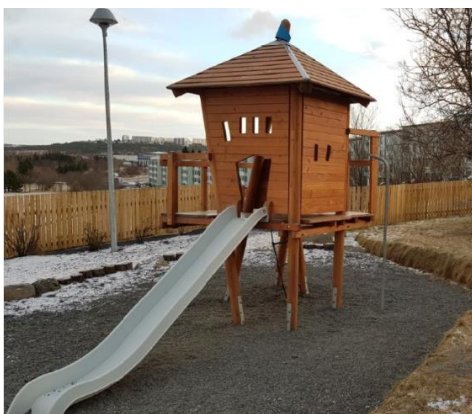
Myndir 12 og 13. Tvö tæki á nýrri lóð leikskólans Álfatúns. Við turn og rennibraut er 30cm þykk öryggismöl (2-8mm) og við rólu eru annars vegar gúmmíhellur og gúmmímottur á grasi til beggja enda. Allar mælingar stóðust kröfur um falldempun.
