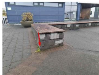
6 Fallhæð - fallhæð af palli er yfir 60cm og þarf dempandi undirlag
