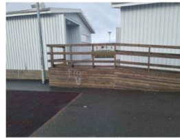
6 Fallhæð - þar sem spýtur eru láréttar er auðvelt að klífra, fallhæð yfir 60cm þarf dempandi undirlag
