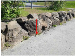
Fallhæð af grjóti er á nokkrum stöðum yfir 60cm og þarf dempandi undirlag.
