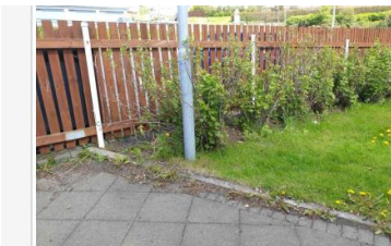
Mála þarf galvaniserað járn upp í 1.5m. Þessi athugasemd á við um alla ljósastaura á leiksvæðinu.
