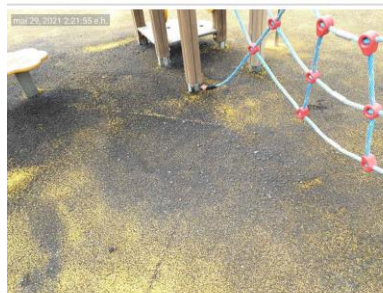
21 Undirlag - mól og óhreinindi á undirlagi
