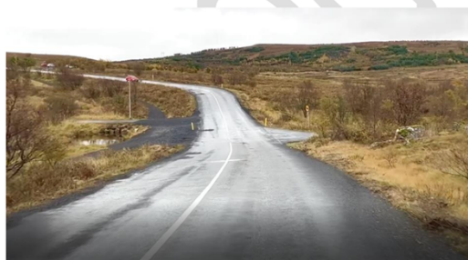
MYND 10 Horft niður að Vífilisstaðalek úr norðri, október 2020. Hér þverar göngu- og reiðleið veginn, möguleiki á að hækka veginn upp til að taka göngu- og hjólaleið undir veginn til að bæta umferðaröryggi.
