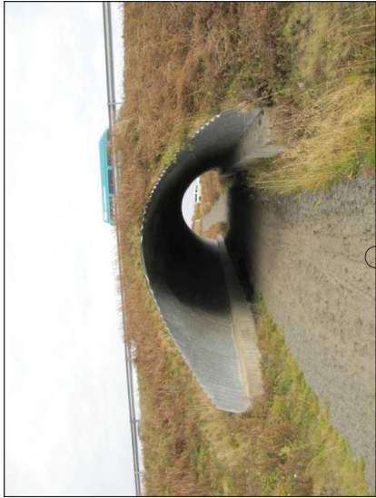
TIL VINDMUNAR REIDGÖNG UNDR SUBURLANDSVEIG NEDAN F JÁRBORGAR. STÆRÐ Á REIDGÖNGUM BREIDD 5.8 m, HÆÐ 4.3 m SANKVÆMT REIDVEGABOK VR OG LH SKAL RYMI Í REIDGÖNGUM VERA MINNST BREIDD 3.0 m OG HÆÐ 3.0 m.
