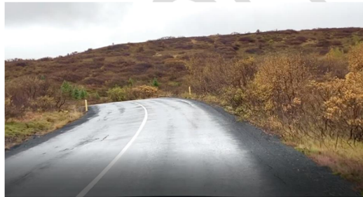
MYND 8 Skert vegrinn áður en komið er að bílastæði við Stekkjartún, ekið í norður októ. 2020.
