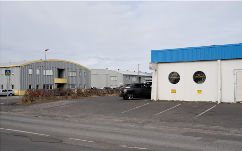
Nýlegt og snyrtilegt atvinnuhúsnaði á athafnasvæðinu.
