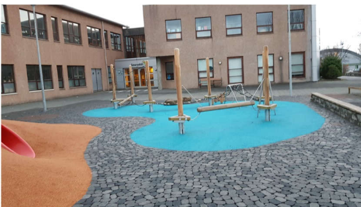
Mynd 6-6. Smáraskóli. Ljós. F.B.
