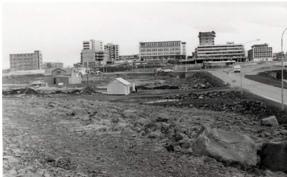
Uppbygging Fannborgar og Hamraborgar um 1975
