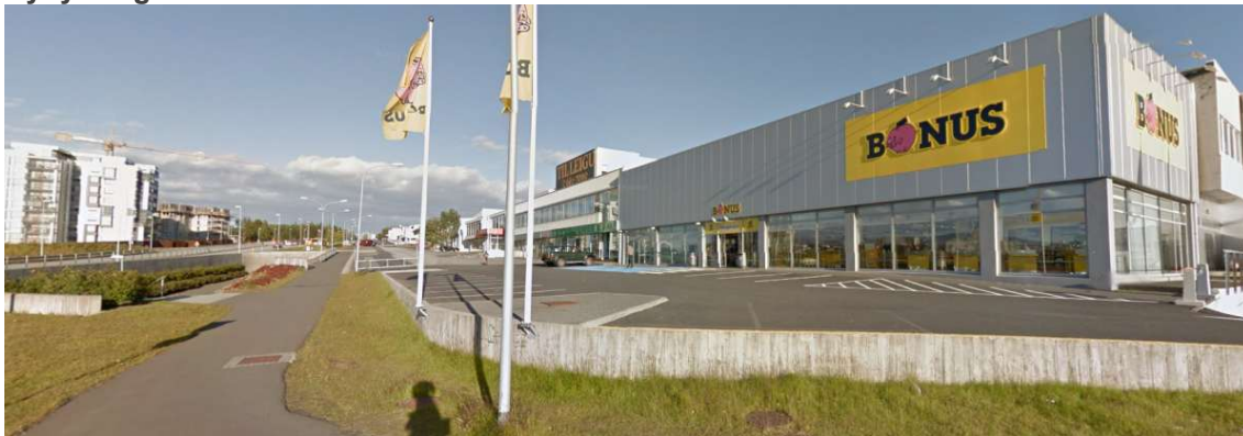
Nýbýlavegur, horft til austurs
