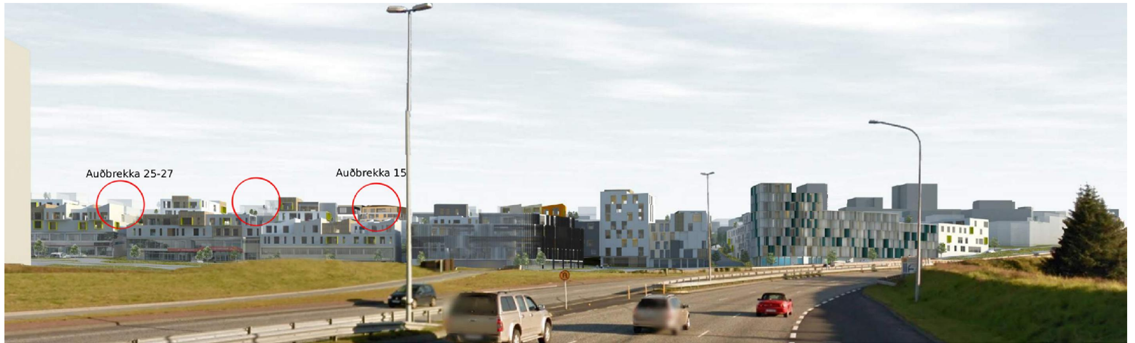
Af Kringlumýrarbraut - horft til suðurs
