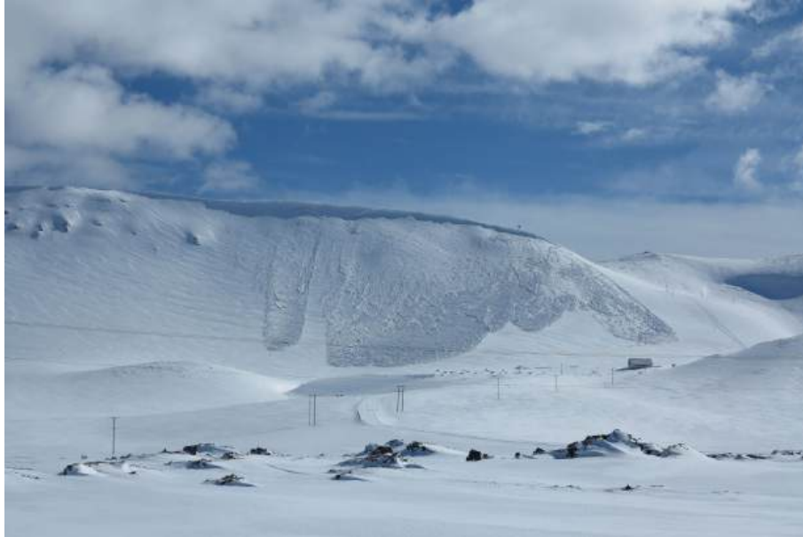
Mynd 4. Stærsta skráða snjöflóðið við skíðalyftuna Kolbein kaftain. Flóðið féll á lyftuna en skemmdir á henni voru litlar sem engar. Framskálinn sést vel hægra megin á myndinni. Sjá má hengjur í fjallsbrúninni. Ljósmynd: Tómas Jóhannesson
