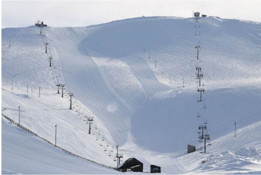
Mynd 15. Skíðalyfturnar gamla Drottningin (sem hefur núna verið fjarlægð) og Kóngurinn. Annað og þriðja mastur gömlu Drottningarinnar voru í upptakasvæðum 31 og 32.
