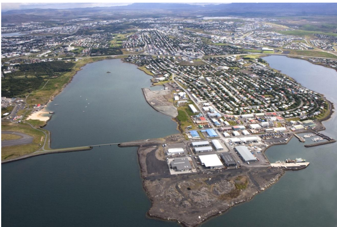
Mynd 16 – Horft til austurs inn Fossvog, 100 m löng hjóla- og göngubrú
